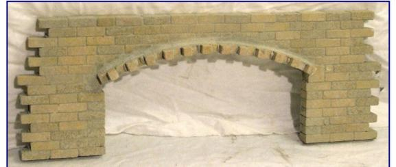
**unten:** Ansicht des gebauten Seitenteils Innenansicht im Liegen. Das Gewölbe wird auf das Seitenteil im Liegen aufgebaut. Bitte 90°-Winkel beachten. Das macht die Sache leichter... :-))
